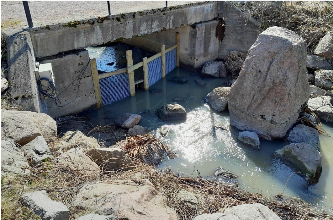
Kuva 2. Kalalaskuri asennettuna kalatien ylittävän betonisillan alle. Kuva otettu alavirrasta ylävirran suuntaan.
